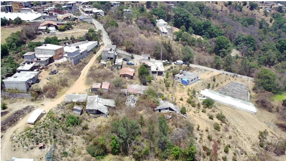
Asentamientos humanos ubicados sobre un deslizamiento de tipo traslacional en la localidad de Primera de San Miguel.
